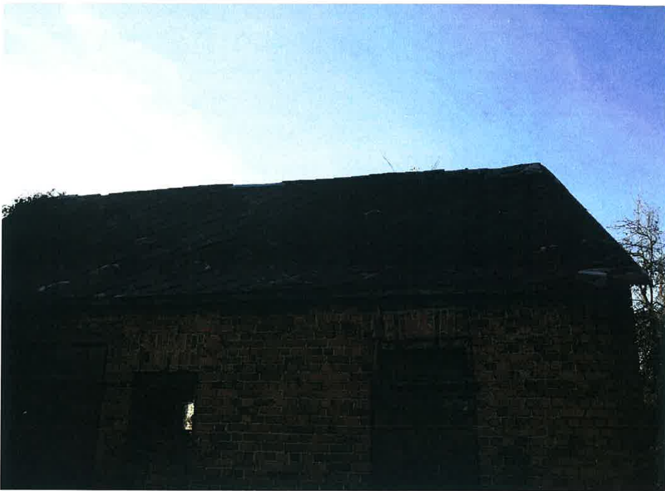
Nr. 4 Pastatas iš šiaurinės pusės
