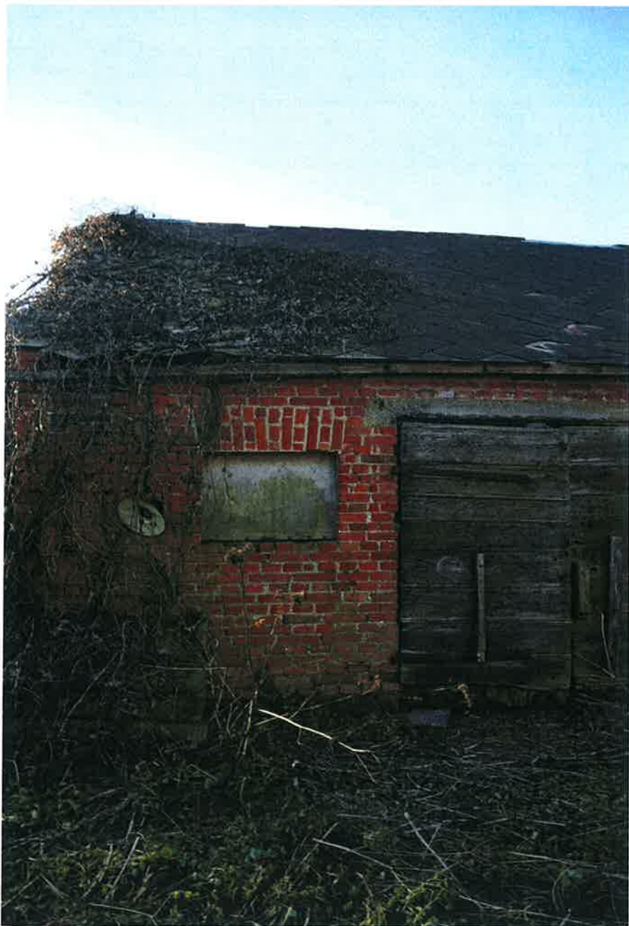
Nr. 6 Pastatas iš šiaurinės pusės
