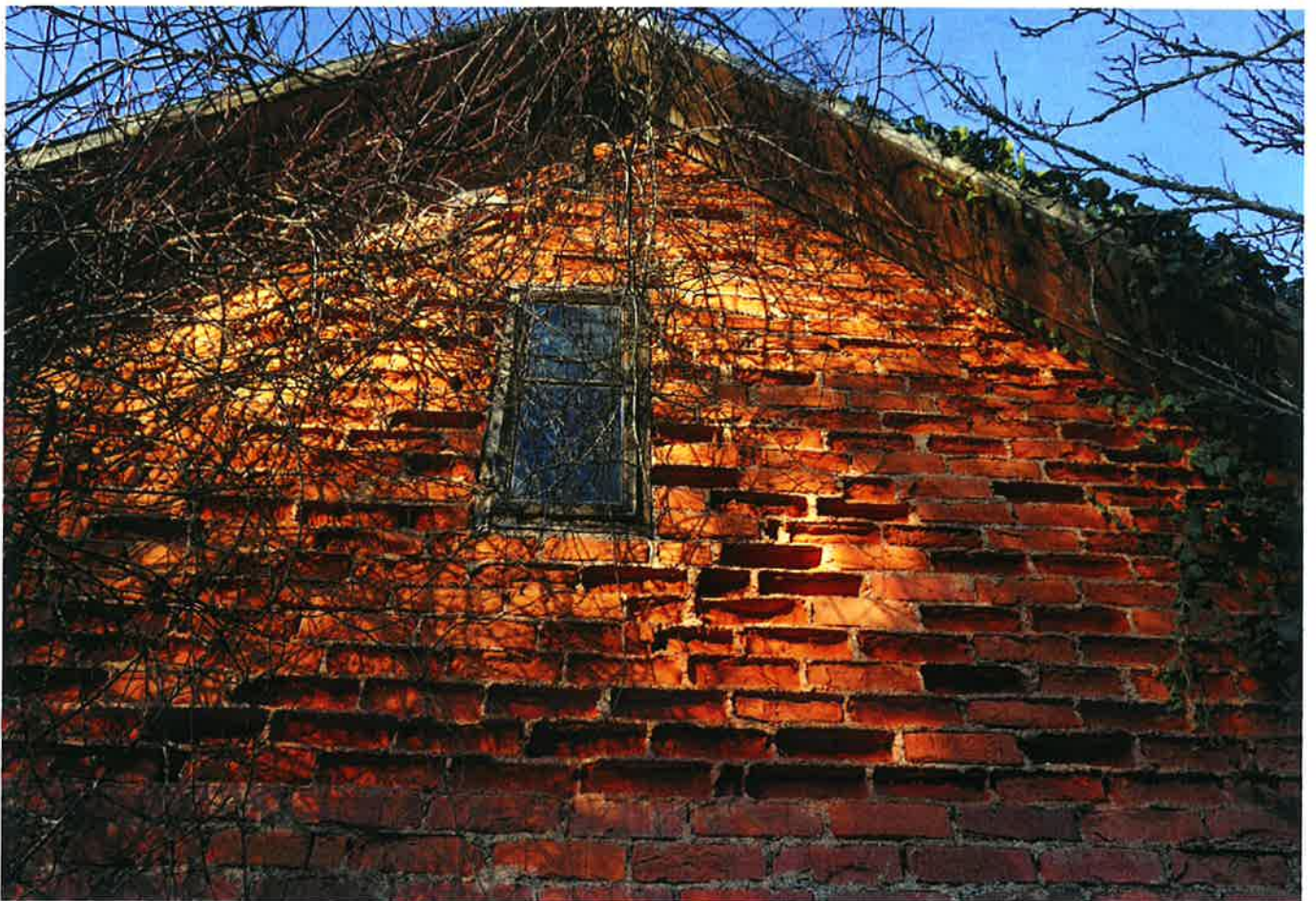
Nr. 5. Pietrytinė pastogės dalis. Ištrupėjusios plytos . Rišamoji medžiaga šiuo atveju stipresnė už plytas.
