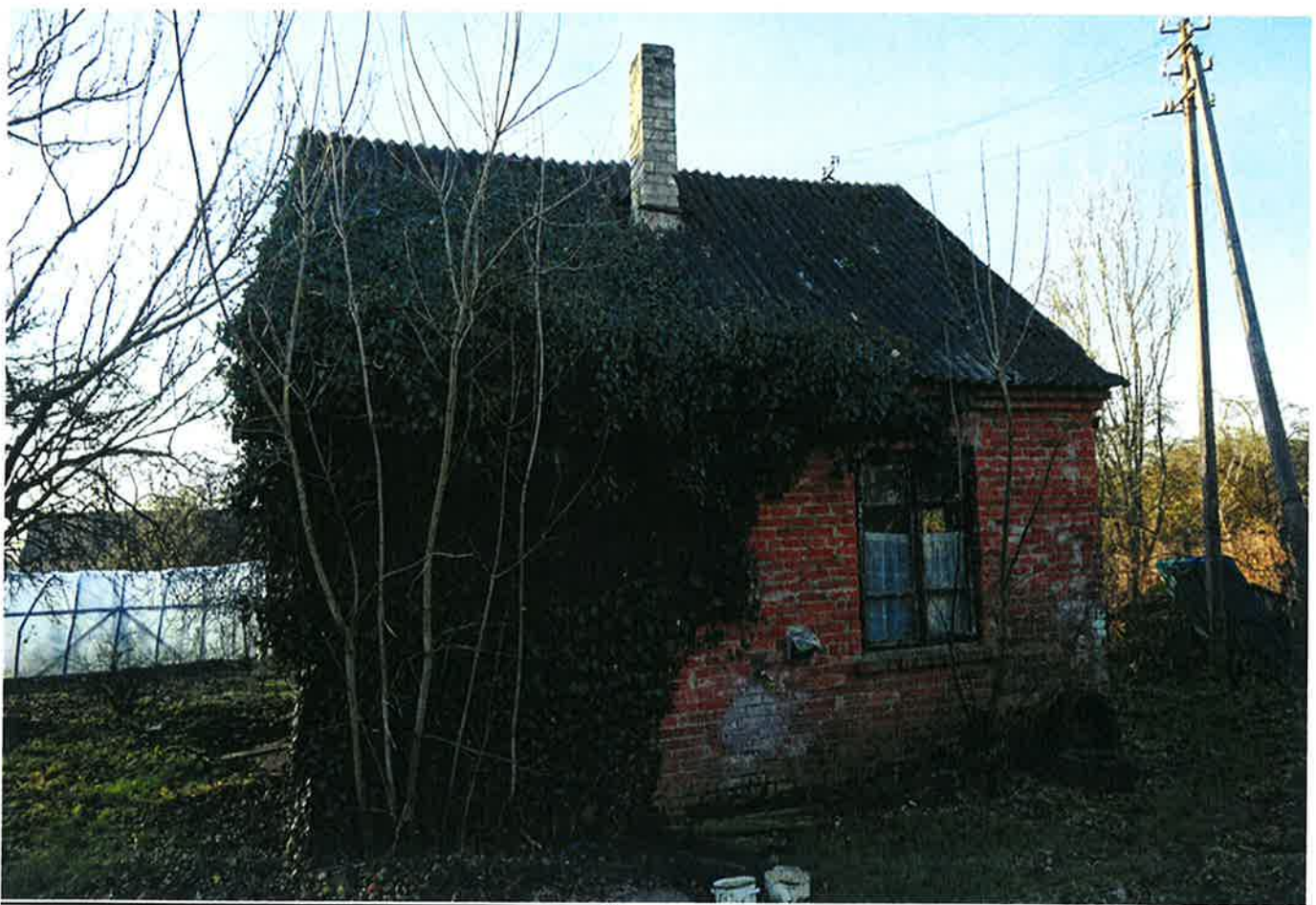
Nr. 1. Dalis šiaurinio pastato apaugusi gebene lipiku. Šio augalo orinės šaknys kenkia pastatui, būtina jį pašalinti.
