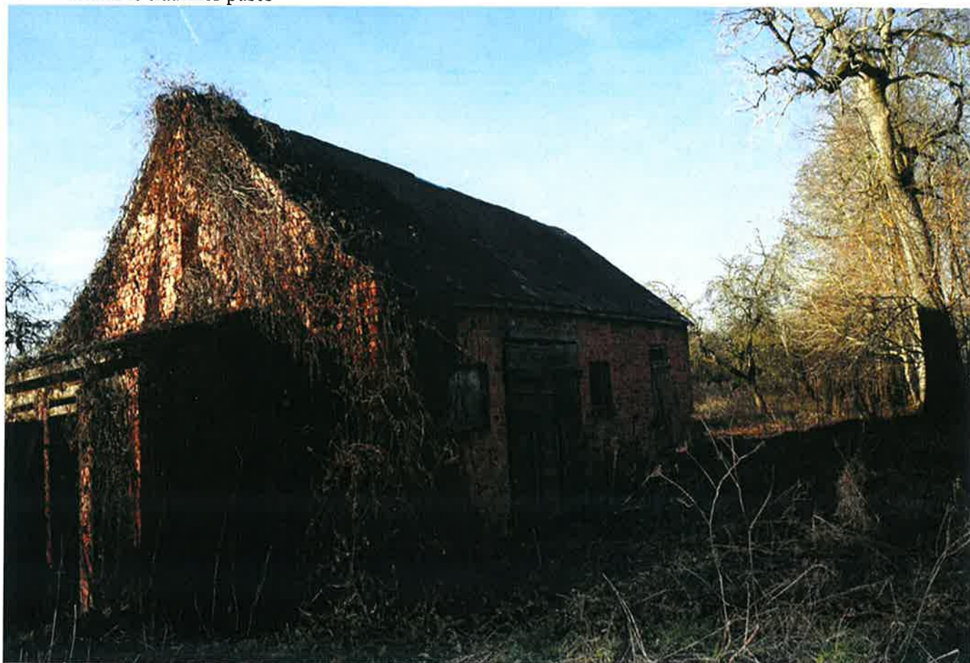
Nr. 5 Pastatas iš šiaurinės pusės
