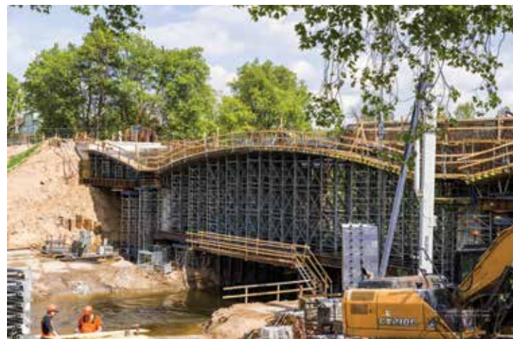
Rekonstruojamas Kudirkos Naumiesčio tiltas
