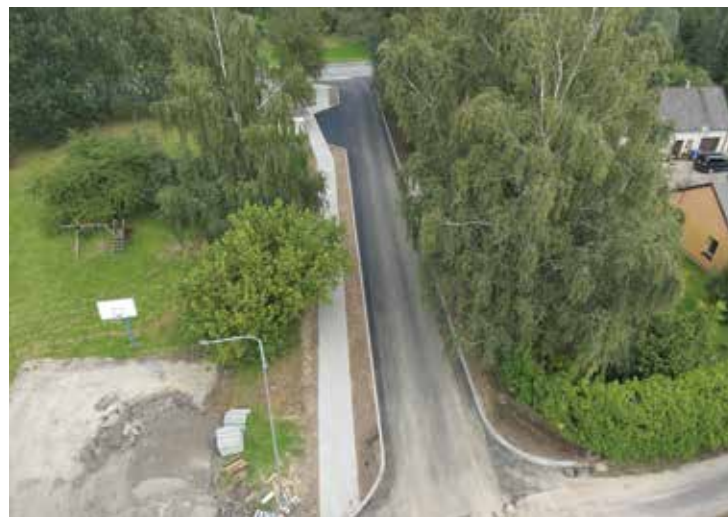
Šakiai, Griškabūdžio g. – atnaujintas įvažiavimas į daugiabučių namų kiemus ir atliktas pėsčiųjų tako remontas.
