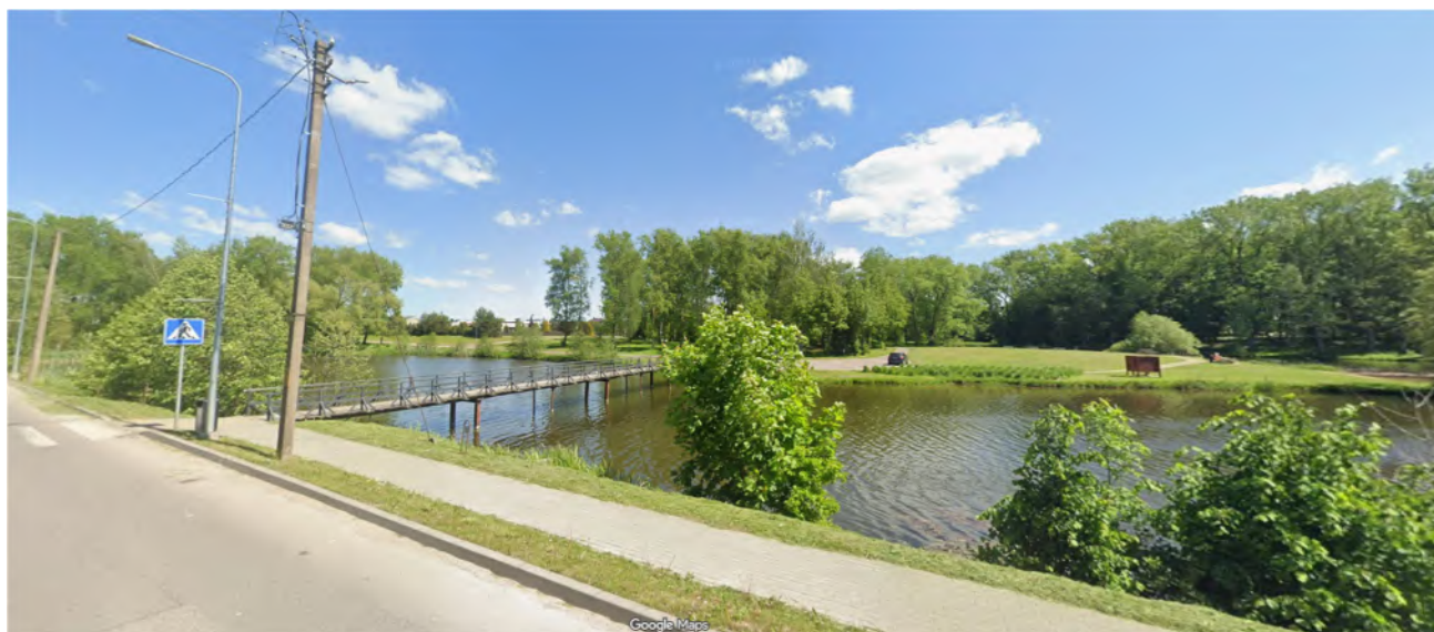
3. pav. Esama situacija. Esamas pėsčiųjų tiltas, šiaurinė tvenkinio pusė, Sklypas Nr. 01
