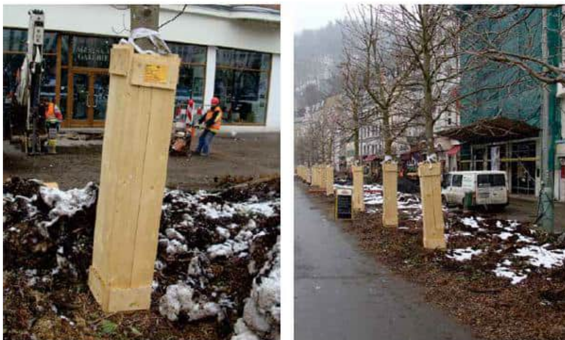
9 pav. Galima medžių kamienų apsauga vykdant darbus
