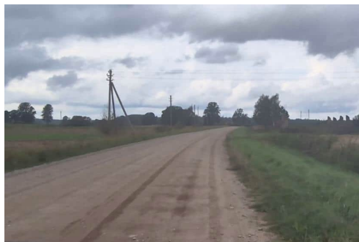
3 pav. Esama kelio būklė
